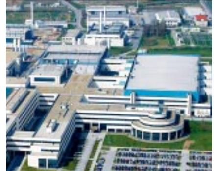
*Une deuxième unité de cogénération\* d'électricité et de vapeur a été inaugurée en avril 2005 sur le site d'AMD à Dresde en Allemagne. La cogénération a un rendement énergétique supérieur de 15 à 20 % par rapport aux techniques de production séparée d'énergie et de vapeur. Elle réduit dans les mêmes proportions les émissions de gaz carbonique dans l'atmosphère.*
