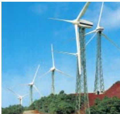
Génératrices d'énergie "propre", les éoliennes sont en plein essor.
