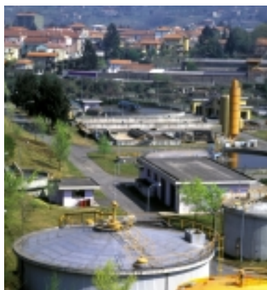
La station d'épuration de Verbania en Italie.
