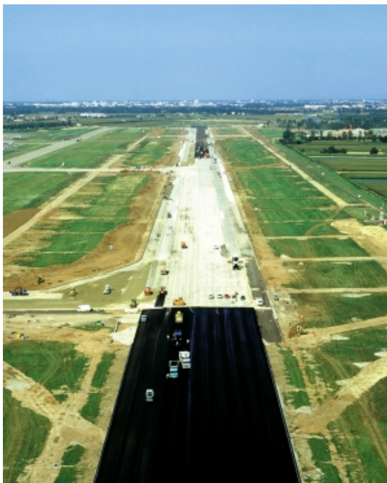
Reconstruction de la piste de l'aéroport d'Entzheim à Strasbourg.
