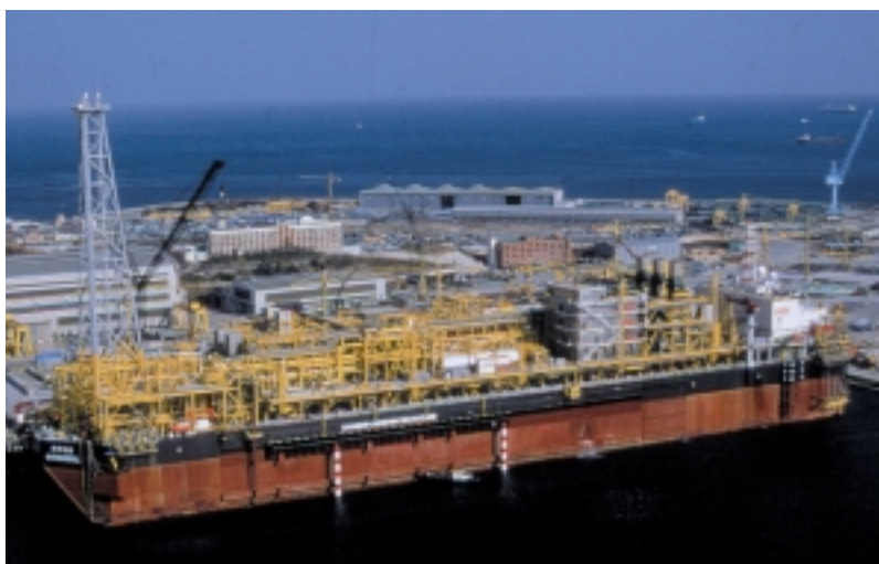
L'unité flottante de production FPSO pour le projet Girassol en Angola.
