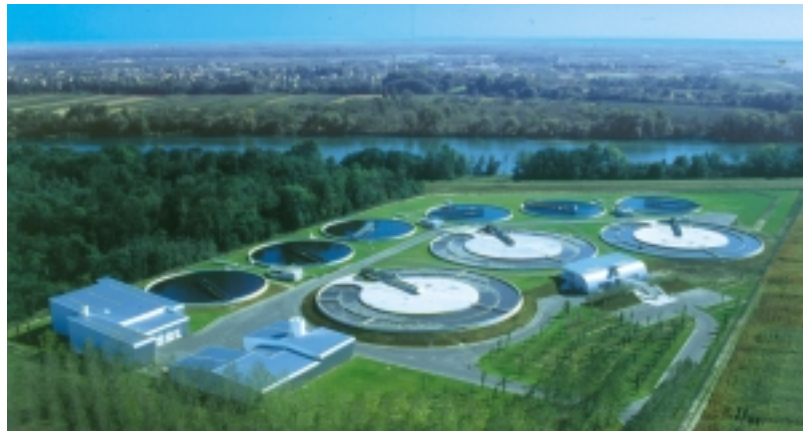
La station d'épuration d'Orléans est certifiée Iso 14001.
