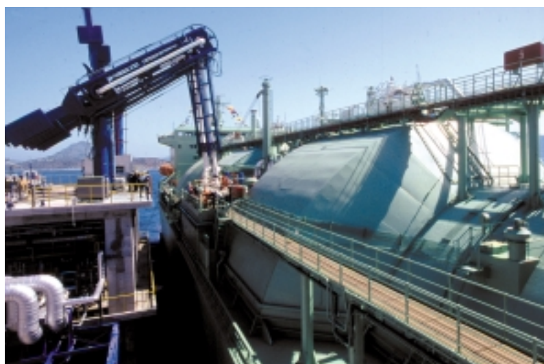
Le terminal gazier (gaz liquéfié) de Revithoussa en Grèce, construit par Bouygues Offshore.
