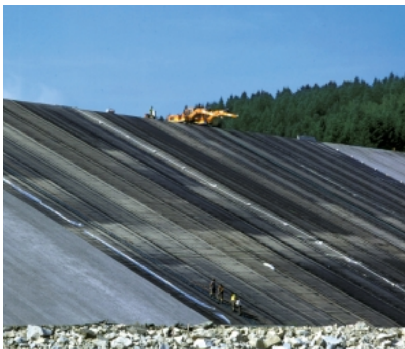
Masque amont du barrage de la Galaube en Colétanche.
