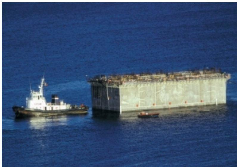
Transport des caissons préfabriqués pour la digue de Monaco.
