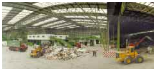
Centre de tri de déchets Fabricom.
