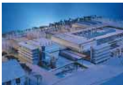
Maquette de l'extension future de la station d'épuration des eaux usées du Caire (Gabal el Asfar).
