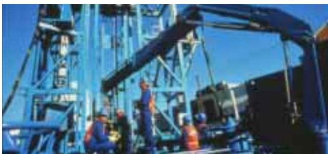
Nettoyage d'égouts à Buenos Aires par Agua Argentinas.
