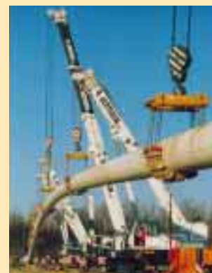
Pose de tuyau de l'Interconnector.
