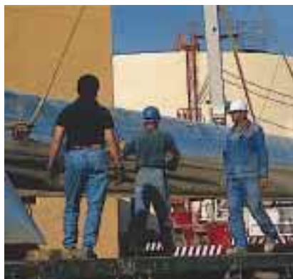
Construction par Elyo d'une centrale de trigénération sur le site de la dernière Exposition Universelle du siècle à Lisbonne, Portugal.
