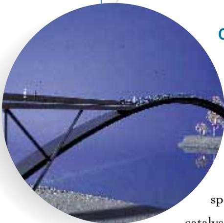
Projet de la "Passerelle de la Paix" à Séoul (Corée du Sud) : grâce au Ductal®, l'épaisseur du tablier de cette future passerelle ne sera que de 3 cm pour une portée de 120 mètres.
