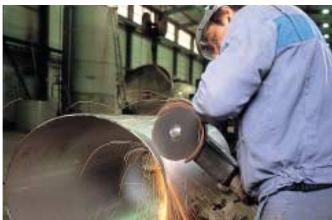
Tronçonnage de cuve inox. Meule mince.
