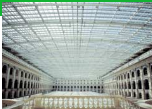
Nouveau centre commercial Gostiny Dvor à Moscou, comprenant 4000 m 2 de verre Eglass et dont les parois intérieures sont recouvertes de panneaux acoustiques Ecophon .
