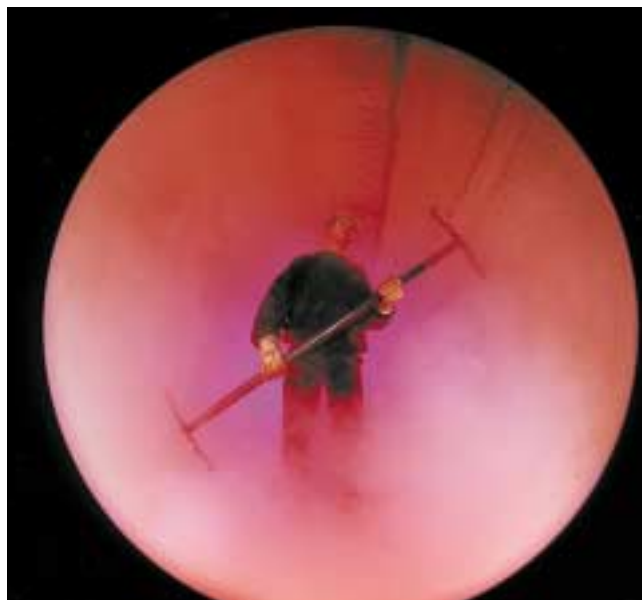
Contrôle diamètre intérieur DN 2000.
