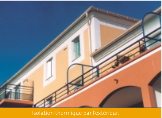
Isolation thermique par l'extérieur.
