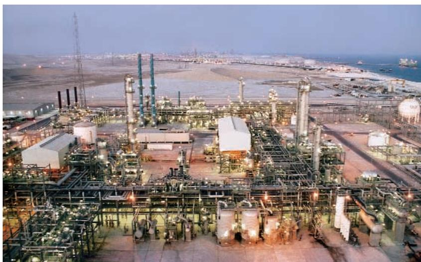
La construction des utilités, des offsites et du réseau de pipelines liés au développement du champ gazier d'Haradh est en voie d'achèvement. Ces installations destinées à servir une nouvelle usine de traitement de gaz de 16,2 milliards de m<sup>3</sup>/an, seront achevées et livrées par Technip-Coflexip à Saudi Aramco au cours de l'été 2003 ainsi que l'unité de compression de LGN (liquides de Gaz Naturel) construite à Abqaiq.
