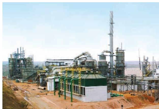
Technip-Coflexip s'est vu confier successivement l'ingénierie de base, puis la maîtrise d'œuvre de la section de craquage et de la section d'oxychloration d'une usine de 200 000 tonnes/an de VCM (chlorure de vinyle monomère) pour VCM Tianjin Dagu Chemicals Ltd.
