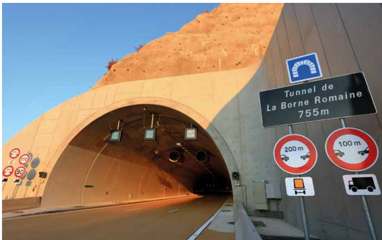
Le tunnel de La Borne Romaine, sur l'A8, a été mis en service en novembre 2016 après trois ans de travaux.
