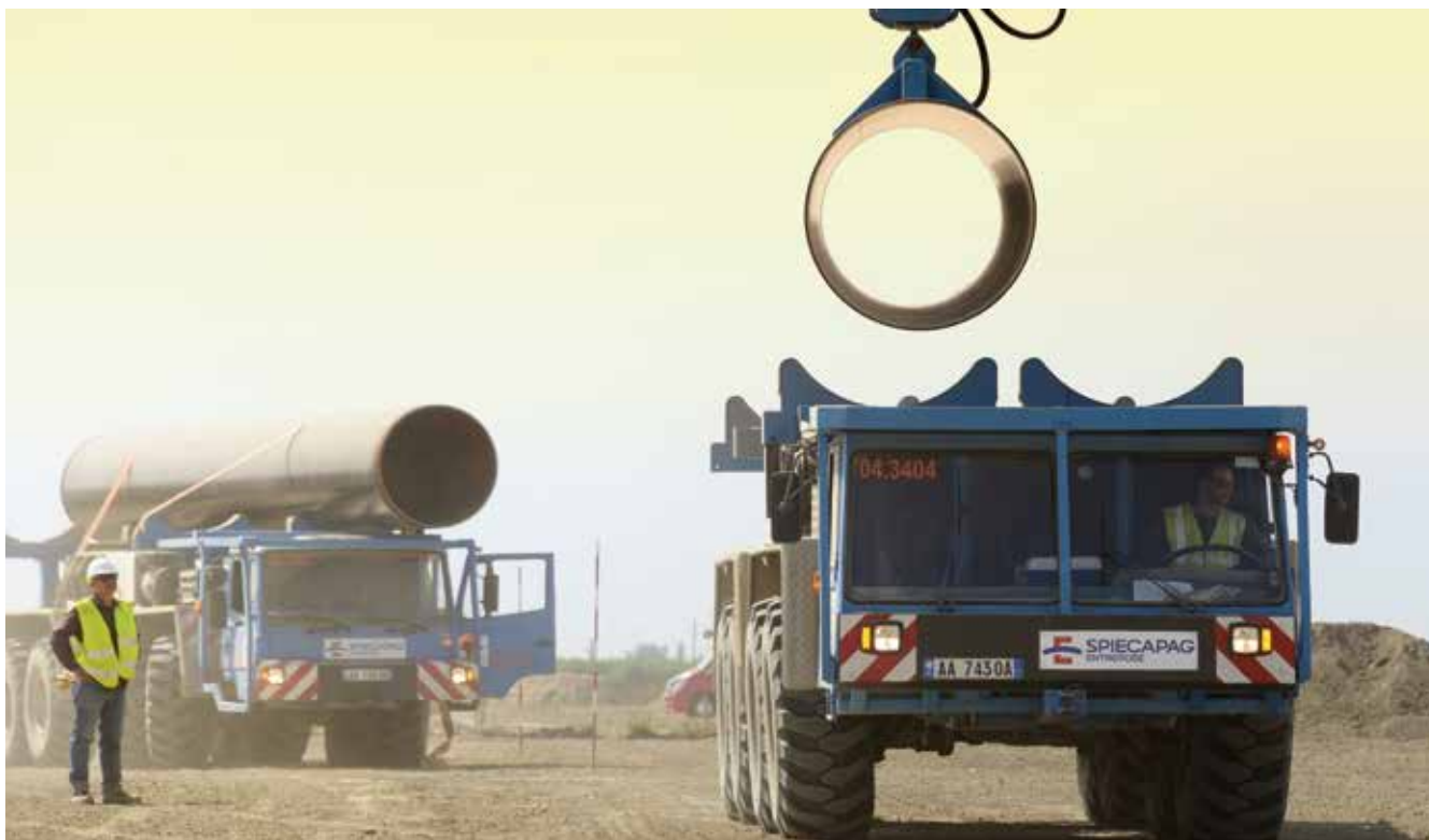
Construction et pose de trois gazoducs terrestres traversant l'Europe de l'Est (Trans Adriatic Pipeline).
